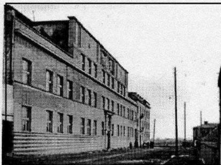
Budynek szkoły 1930r.
